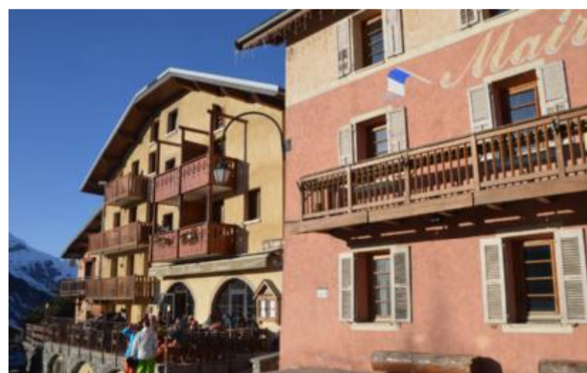
Borgmesterkontoret til højre har slået tonen an for den dæmpede farveskala, der er tilladt på husene i Saint Martin de Belleville. Foto: Michael Brüel
